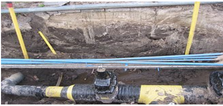
Fig. 40 Ondergrondse leidingen waaronder ook elektriciteitsleidingen.
