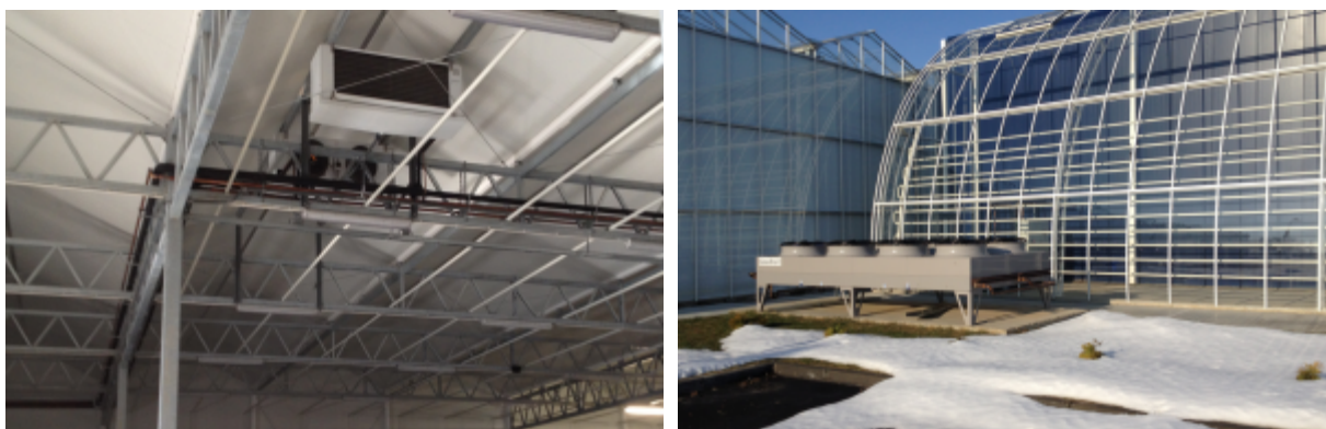
Fig. 132 Vooraanzicht luchtgekoelde koelmachine
